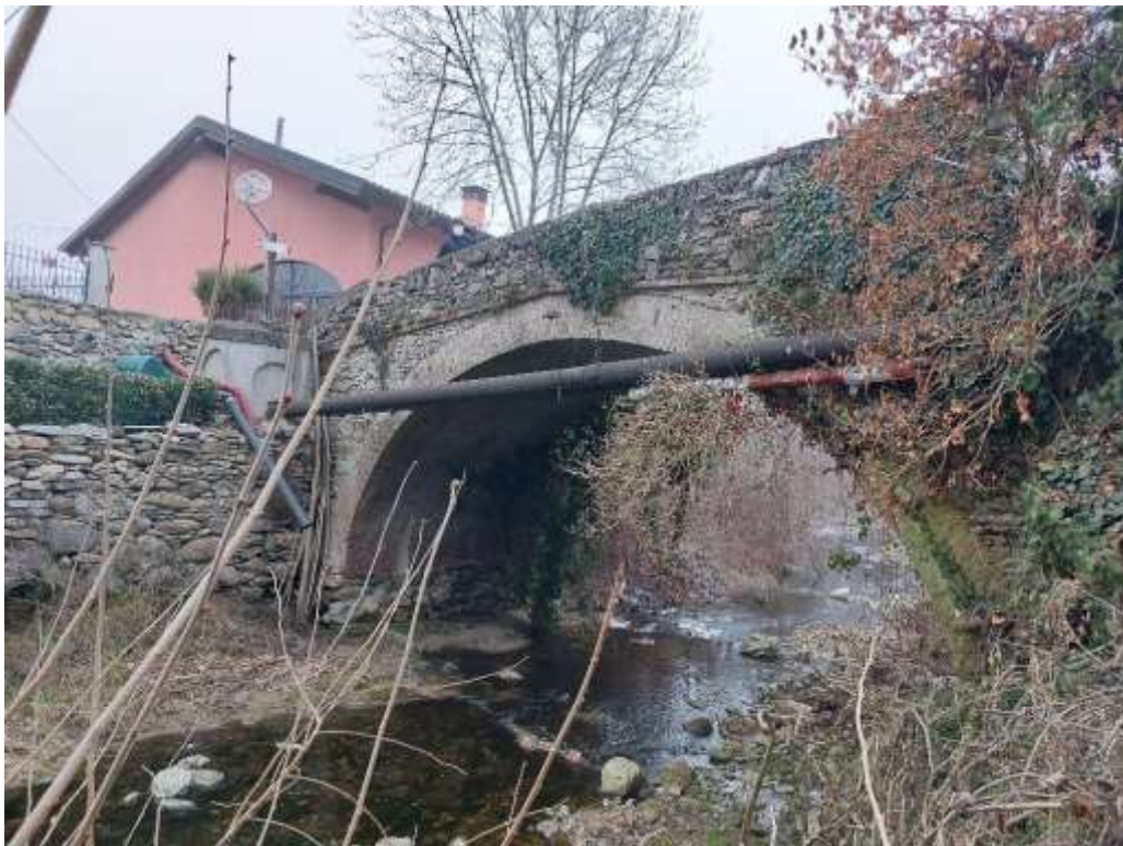
Prospetto est del ponte, visto dall'alveo
