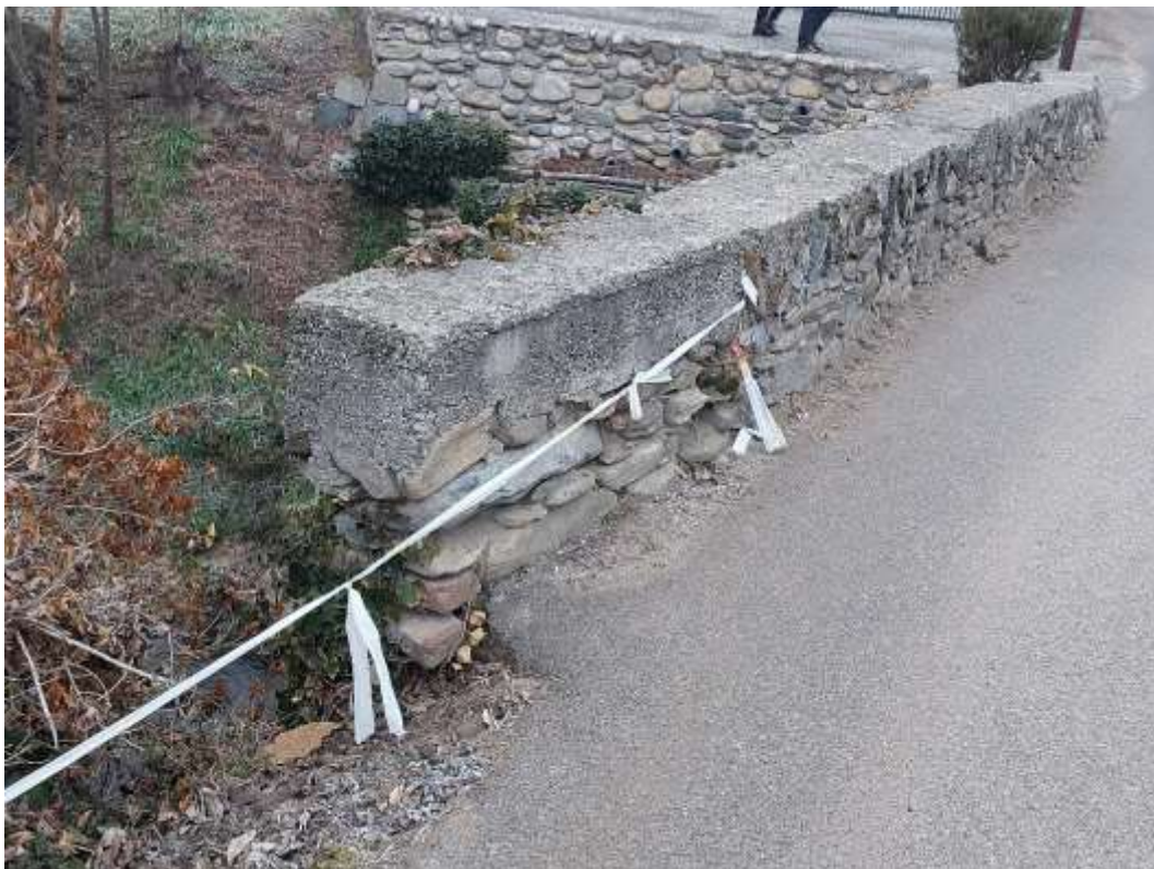
Particolare parapetto in muratura mista e copertina in malta cementizia
