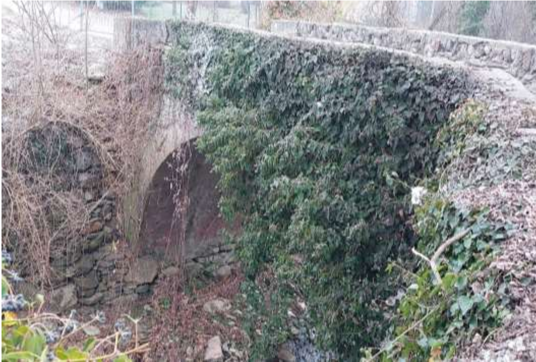
Prospetto ovest del ponte, visto da strada di Pedaggio, lato sud
