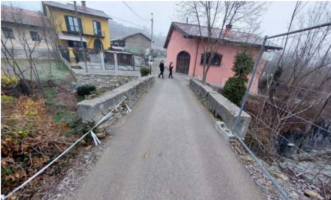
Piano stradale asfaltato, vista da nord
