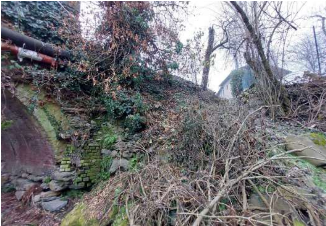
Spalla nord del ponte, vista dall'alveo lato ovest
