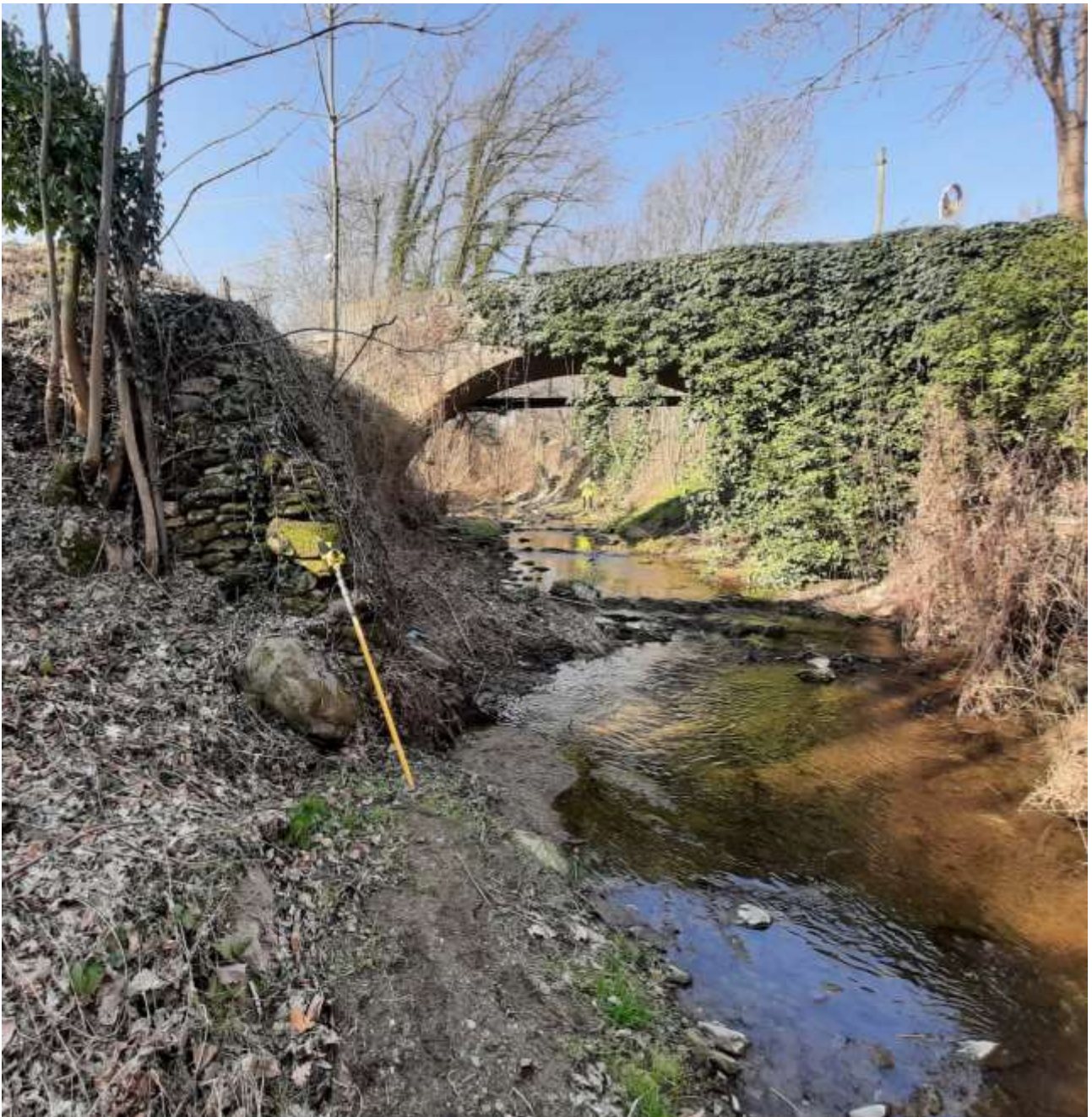
Ponte di Pedaggio visto dall'alveo, lato ovest
