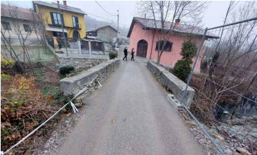
Piano stradale asfaltato, vista da nord
