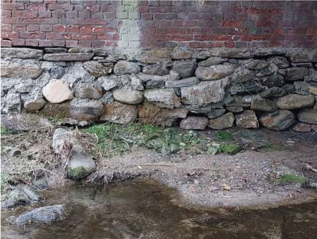
Particolare fondazione del ponte, lato sud
