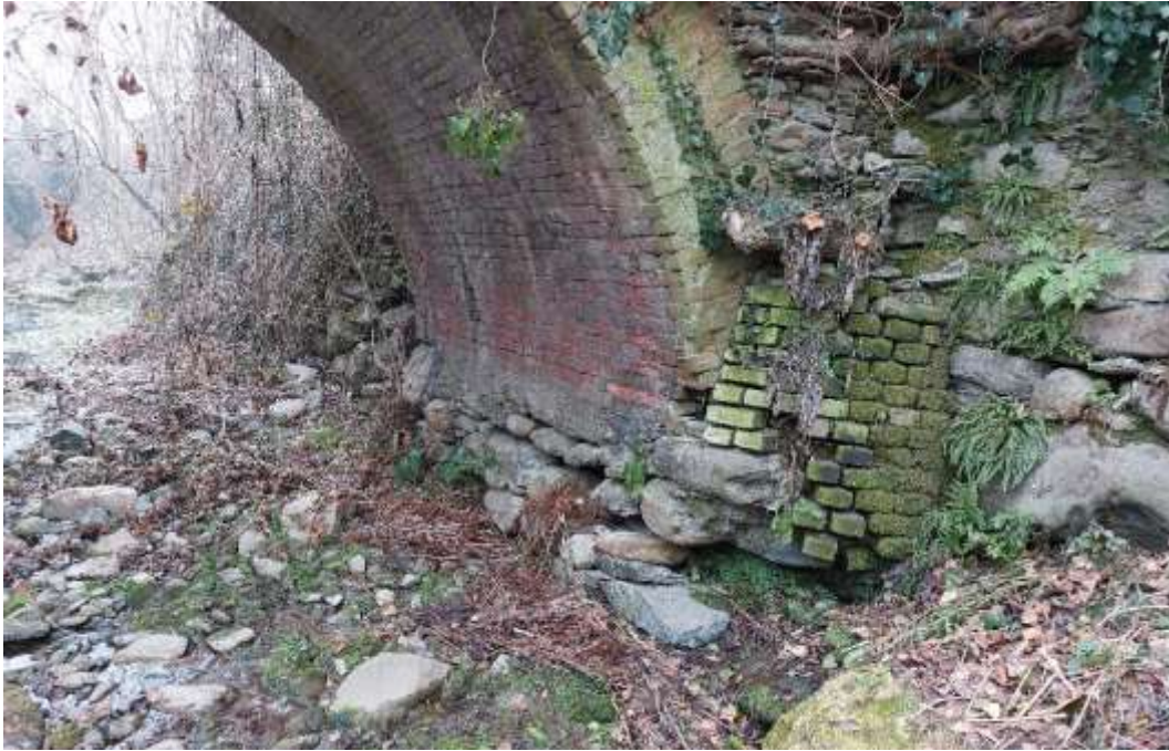
Spalla nord del ponte, vista dall'alveo lato ovest
