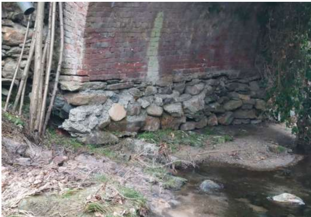
Particolare fondazione del ponte, lato sud
