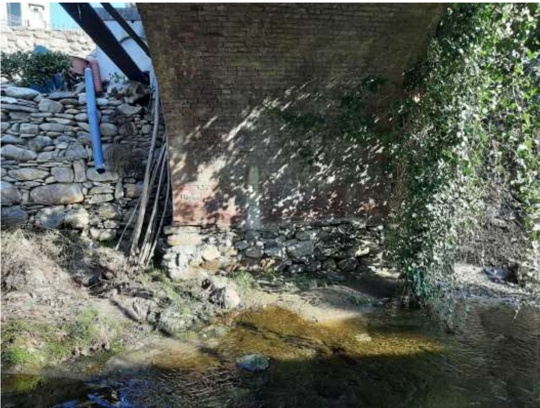
Particolare dell'arcata del ponte, lato sud
