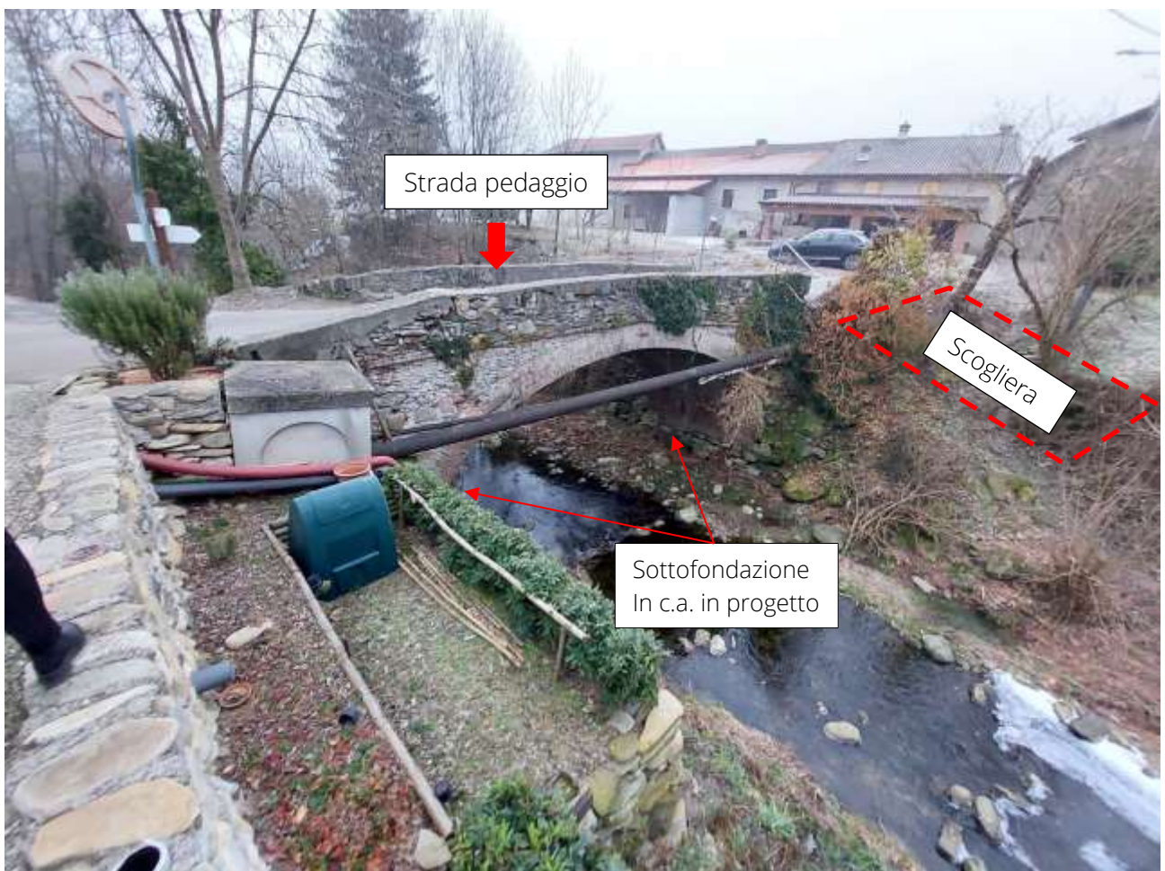
Figura 1 - Inquadramento fotografico dello stato attuale
