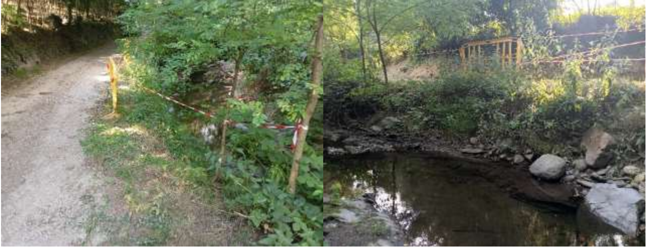
Figura 3 - Inquadramento fotografico dello stato attuale - Intervento C - Località Pedaggio
