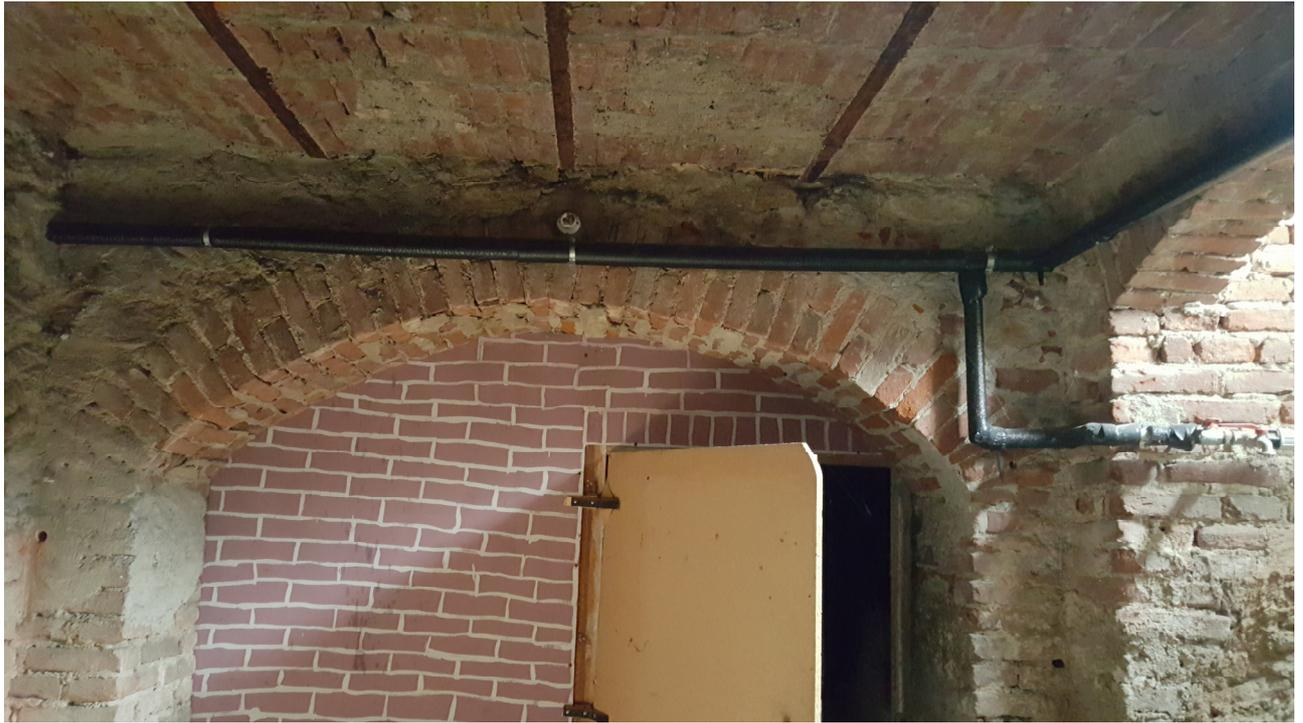
Caratteristiche della muratura e verifica dell'ammorsamento tra maschi murari al piano interrato
