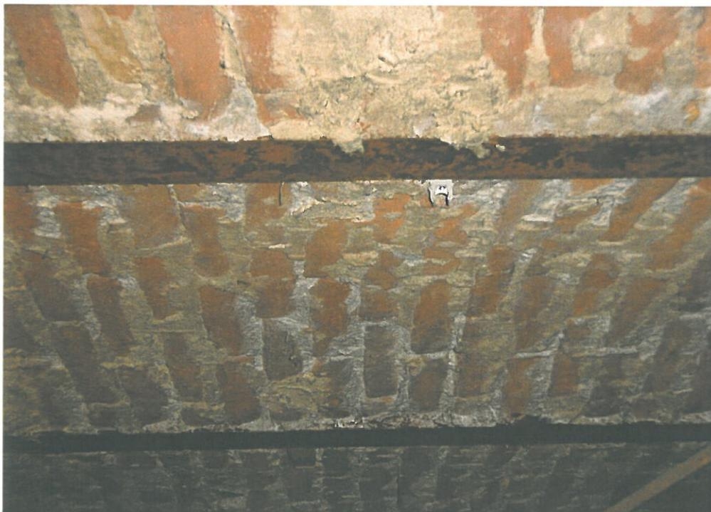
*Vista di uno dei solai in putrelle e voltine a copertura dell'interrato.*
