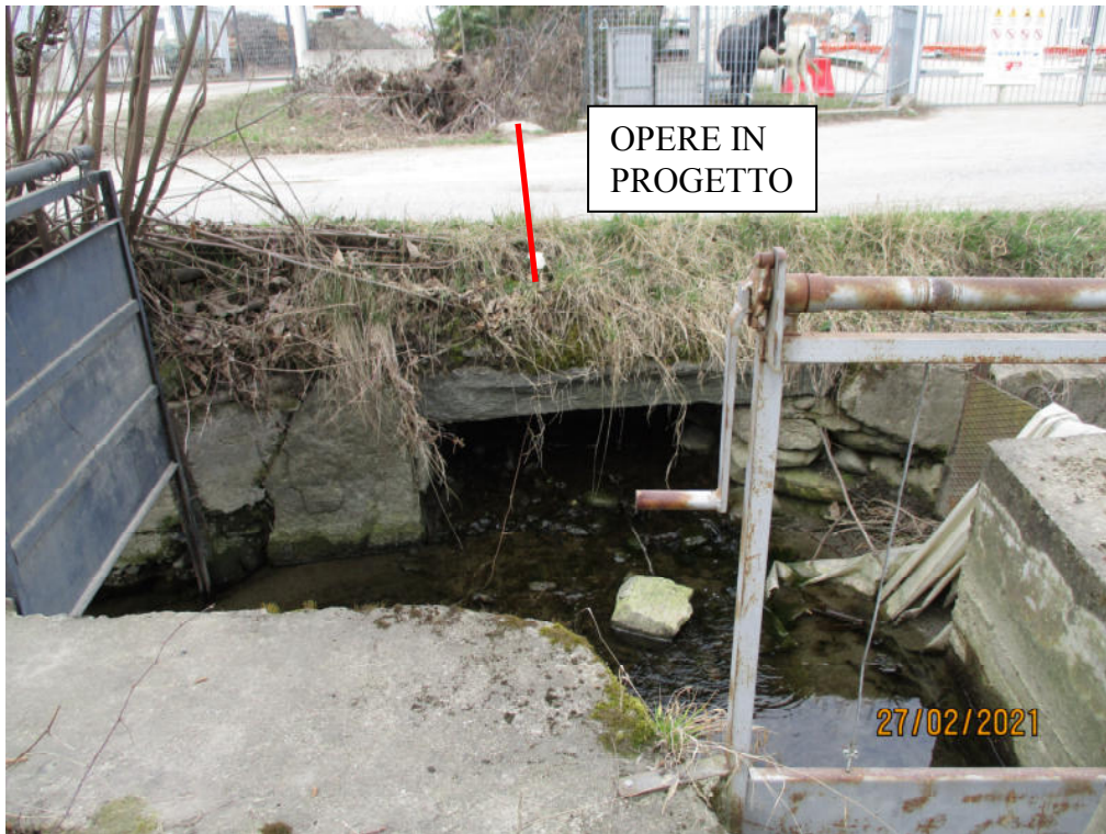
VISTA LATO DESTRO DA STRADA BRAIDE
