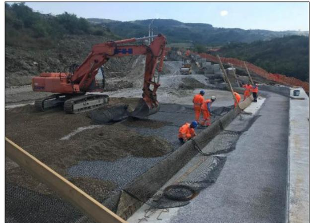
Fase 5: FISSAGGIO DELLA STAFFA DI RINFORZO: dopo la stesura della geogriglia e della stuoia, va fissata una staffa di rinforzo in tondino di ferro analogo a quello usato per il cassero, per evitare l'apertura del cassero sotto le pressioni che si svilupperanno nella fase di compattazione: è buona norma inserirne in ogni cassero almeno una ogni 60 cm.
