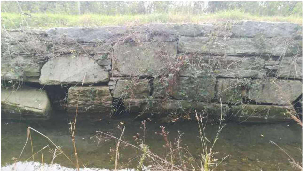
Vista di un tratto di inserimento della massiciata in progetto, a sostegno della scogliera esistente erosa
